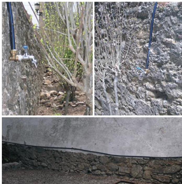
Grifo y goma colocados para suministrar el agua
